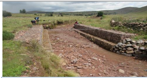
FOTO 02: Cauce del río Chaquimayo, se aprecia el paso del sistema de agua potable Cholloccani y aguas abajo afectadas por erosión la
