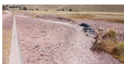
FOTO 06: Río Chaquimayo se aprecia el desborde del río por la margen izquierda aguas abajo, cauce colmatado, requiriendo la limpieza de sólidos y descolmatación del cauce.
