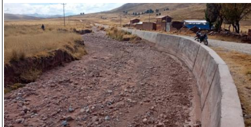
FOTO 05: Cauce del río Chaquimayo con defensa ribereña margen derecha aguas abajo. Dique de concreto ciclopeo.
